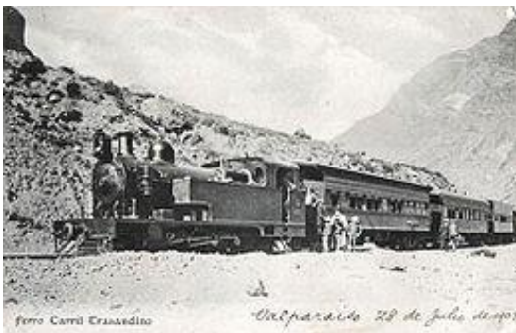
Locomotive Kitson-Meyer articulée n°4 à voie métrique qui circula dès 1909 sur le réseau FCTC Santa Rosa de Los Andes-Cumbre
